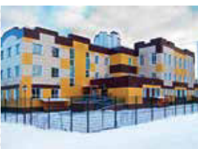
ДОУ Шувалово-Озерки, г. Санкт-Петербург
