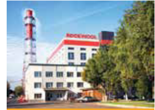
Завод Rockwool, г. Железнодорожный
